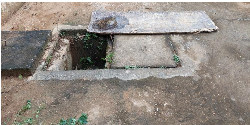
Hình 4. Hình ảnh hố ga tại cơ sở
