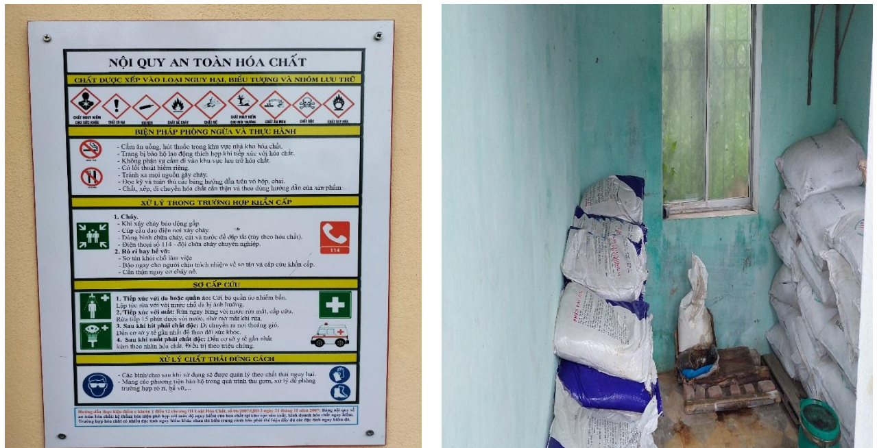
Hình 3. 8. Kho hoá chất và bảng nội quy an toàn hoá chất tại Trạm cấp nước
