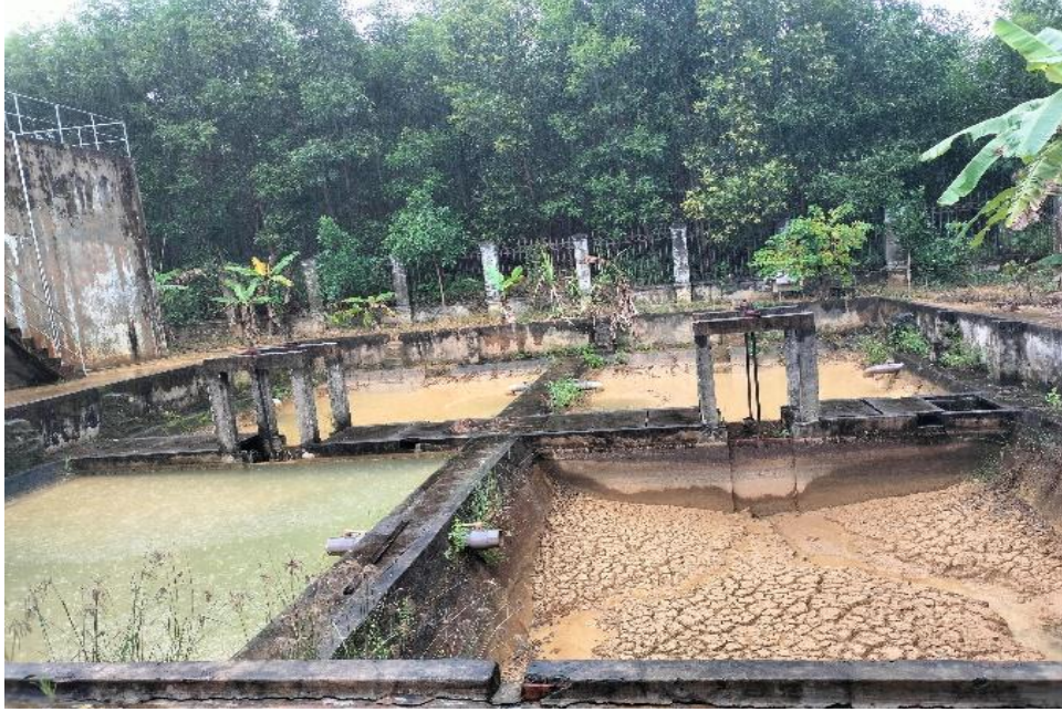
Hình 3. 6. Công trình xử lý nước thải
